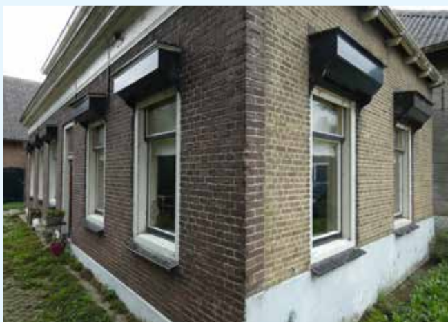
Een voorbeeld van een woonhuis met houten rolluiken in getimmerde buitenkasten. Foto: W.G. van Reenen.
