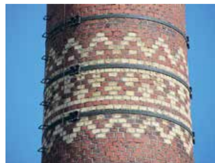
Detail van versierend metselwerk in de fabrieksschoorsteen 'Vier Noorder Koggen'.
