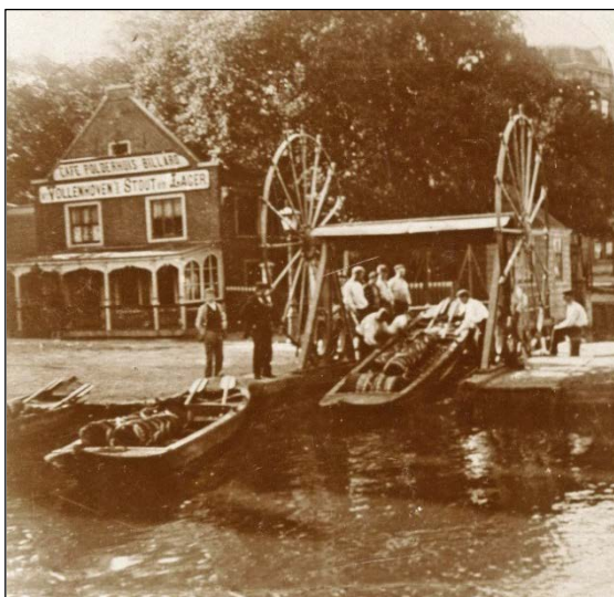
Met de overtoom of overhaal wordt een bootje getild bij het Polderhuis aan de Boerenwetering, Amsterdam. Aardrijkskundige beeldengalerij, verzameld door M.J. Broekhuijsen., uitgave Merkelbach & Co. ca 1900-1902. Rijksmuseum Amsterdam RP-F-11875
