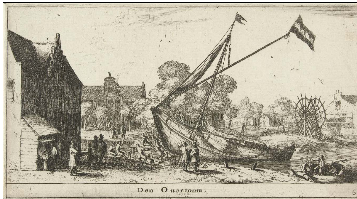
Een schip wordt over de overtoom getrokken, van de Kostverlorenvaart naar de Schinkel. Links vooraan het Leidse veerhuis, bij het begin van de Amstelveenseweg, daarachter de herberg De Valk aan de Sloterkade. De grote overtoom mocht geen windassen hebben. De kleine overtoom wel. Ets van Reinier Nooms datering 1652 – 1654, collectie Rijksmuseum.
